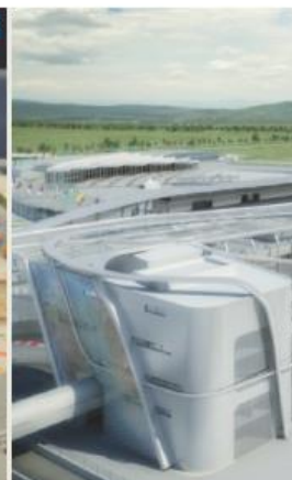
7. SOCHI. Oltre agli impianti per le Olimpiadi invernali di Sochi, la città russa ospiterà il primo Gran Premio nel 2014. L'impianto è in fase di costruzione.
