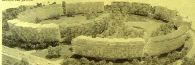
Il risanamento per il complesso di Milano-Santa Giulia
